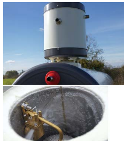
Rys. 7. Kolektor EkoPark ze zbiornikiem pływakowym
