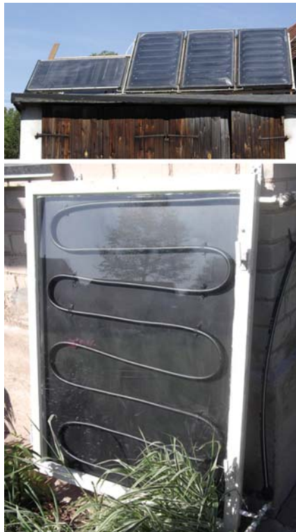
Rys. 3. Inne przykłady kolektorów wykonanych własnym sumptem (źródło: elektroda. pl, tanikolektor. blox. pl)
