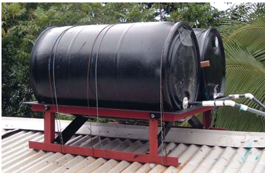
Rys. 1. Najprostsza konstrukcja – dwa zbiorniki plastikowe pomalowane na czarno – może być przydatna w miejscach o ciągłym, bardzo dużym nasłonecznieniu (źródło: gadzetonania.pl)
